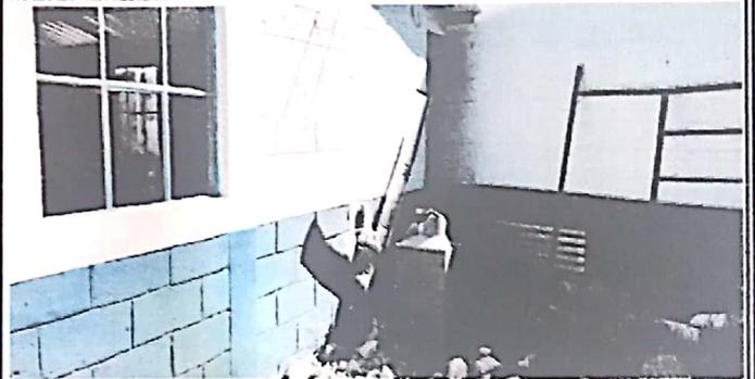
Foto 4: Sustrucion de chimenea
